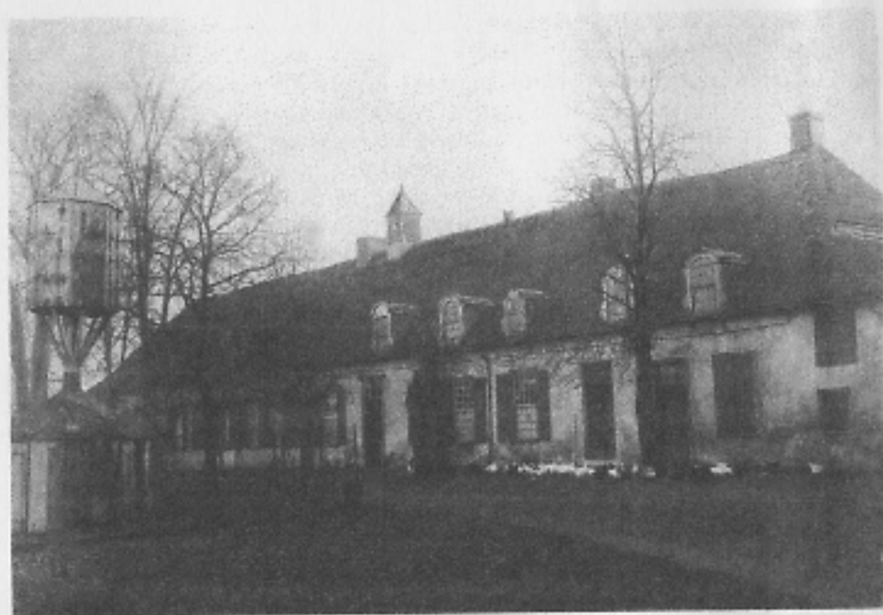
Der alte Kohlenumschlagplatz an der Lippe, das »Kohlhaus« bei Gahlen, Endstation des Kohlenwegs aus dem Ruhrgebiet
